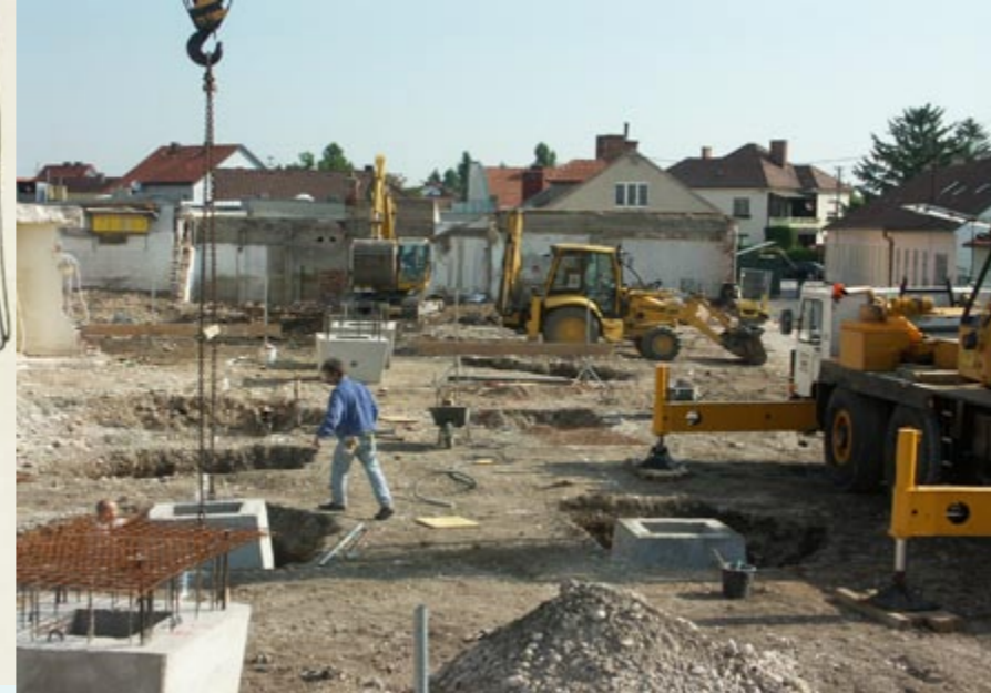
Mai 2005: Beginn der Arbeiten für die erste Baustufe
